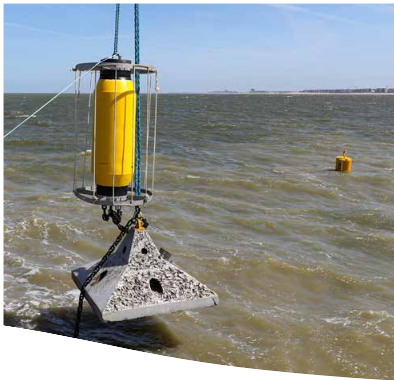
Installatie van de 'mussel shaker'.
