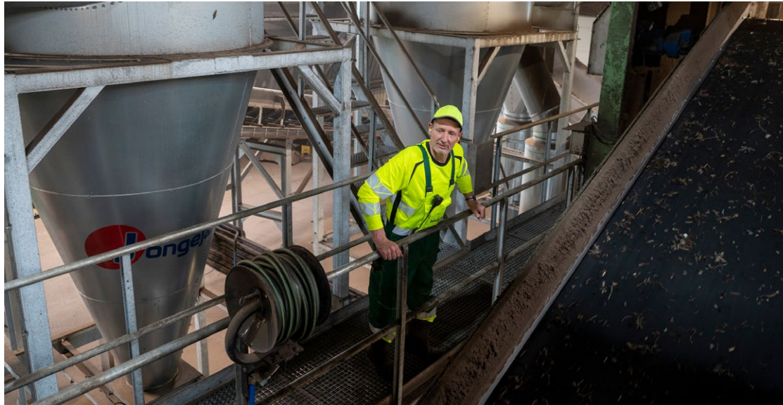
Kwaliteitsverbetering van de compost in de nabewerkingsinstallatie kost meer energie dan voorheen.
