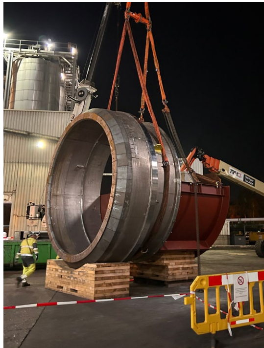
De draaitrommel in Antwerpen (BE) wordt vervangen.
