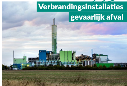
Verbrandingsinstallaties gevaarlijk afval Onze gespecialiseerde verbrandingsinstallaties op hoge temperatuur bieden veilige oplossingen voor de verwerking van schadelijke afvalstoffen. Hamburg (DE) - Biebesheim (DE) - Antwerpen (BE)
