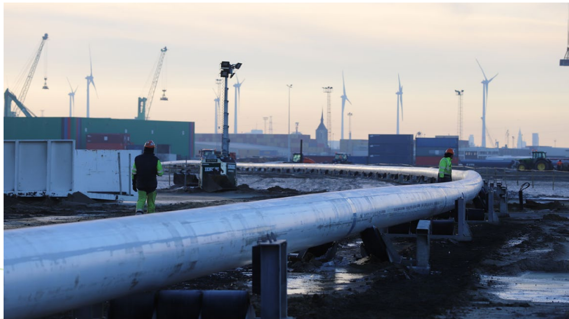
Pijpleiding brengt de restwarmte van onze draaitrommelovens tot bij Boortmalt.
