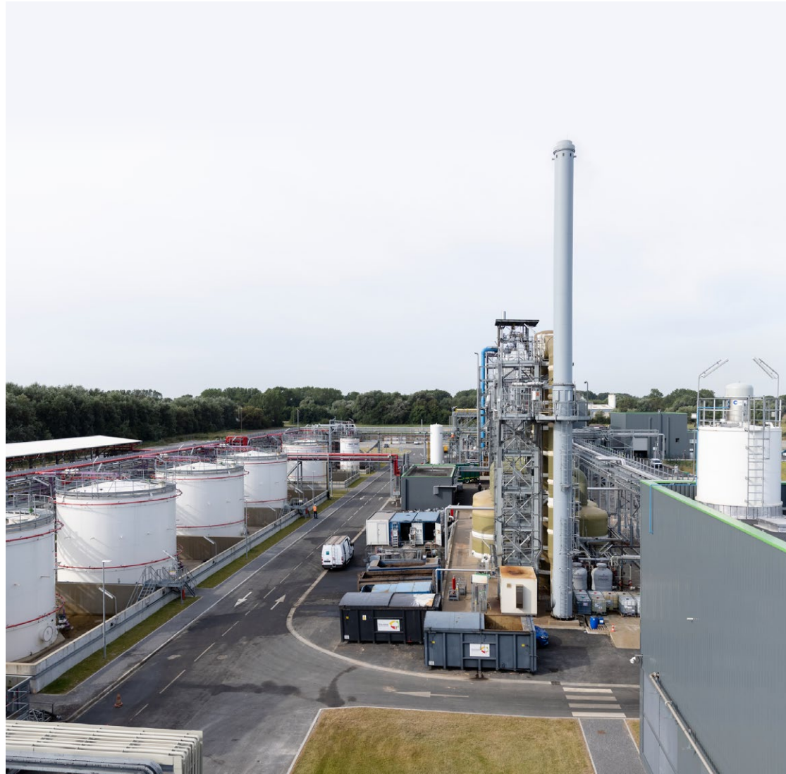
IndaChlor vernietigt bijzonder schadelijk tetrachloormethaan.
