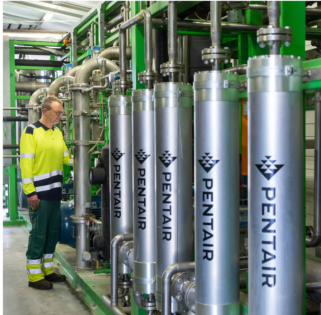
In Alphen aan den Rijn (NL) winnen we CO 2 terug voor toepassing in de tuinbouw.
